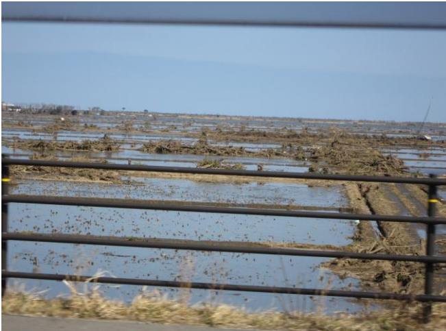
南相馬市津波被害状況 2
