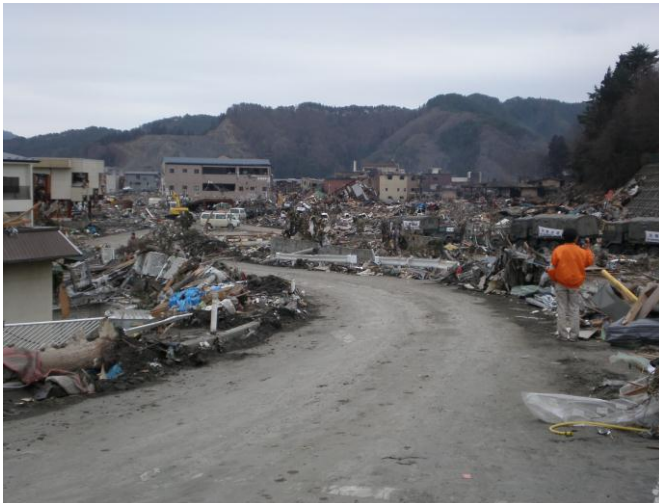
岩手県大槌町の津波被害の様子 2
