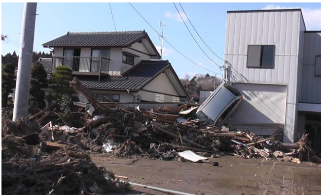
南相馬市津波被害状況 1
