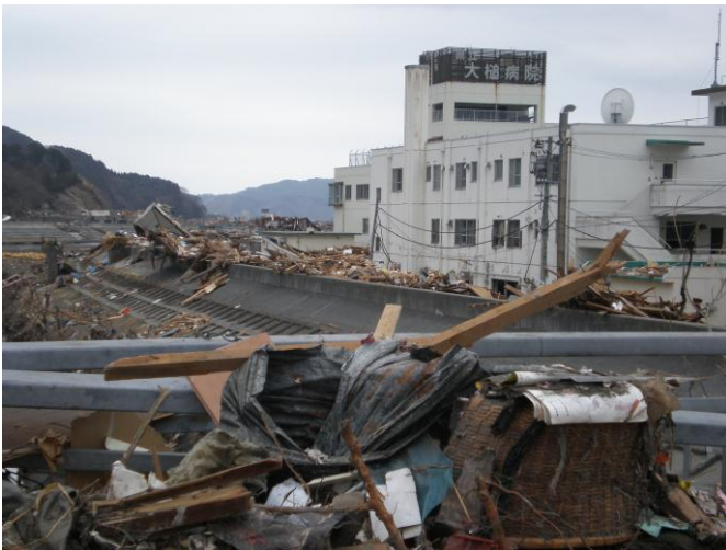
岩手県大槌町の津波被害の様子 1
