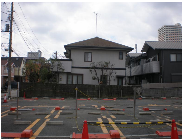
液状化による被害状況 2 (傾く住家)
