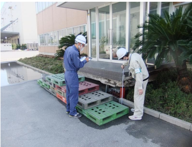
1次調査（外観目視調査）の様子
