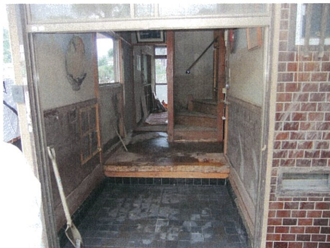
床上浸水家屋の被害状況
