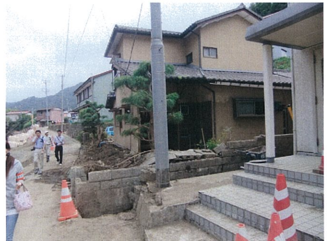
床上浸水の被害家屋
