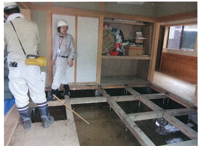
床上浸水家屋の被害状況
