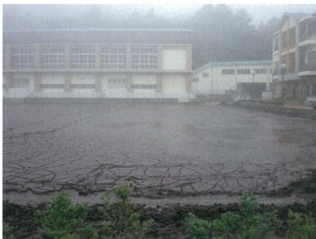
須走中グラウンドに堆積した土砂
