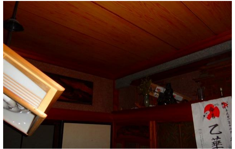
内壁被害の様子（被害なし）
