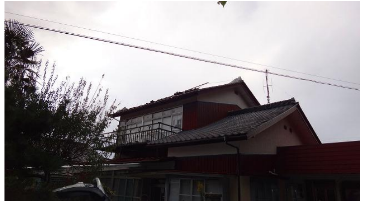
檜葉町坂本氏自宅被害状況
