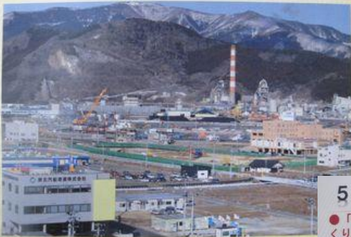
大船渡町中心部で嵩上げ工事が進む大船渡駅周辺整備事業
